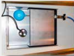
Termostato elettromeccanico di massima temperatura. Electro-mechanical thermostat of maximum temperature alarm.
